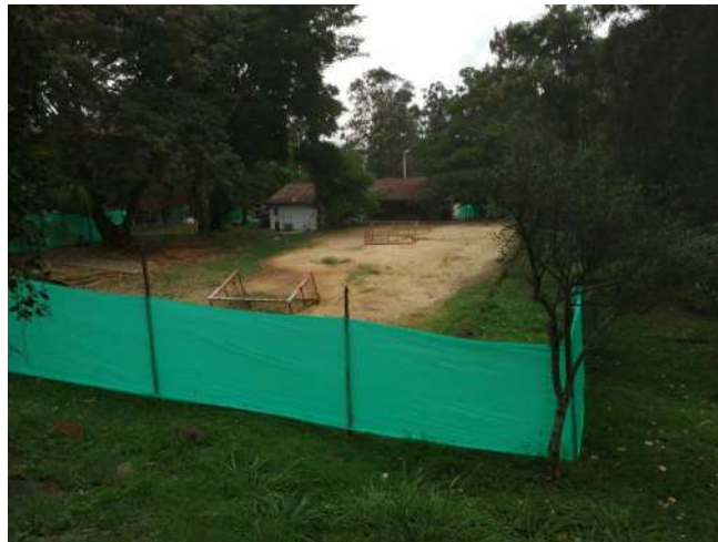
Imagen ilustrativa del avance de la obra
