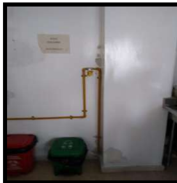
Fuente: Registro fotográfico Red de Gas Bloque 6
