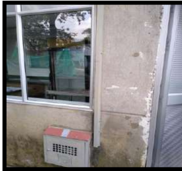
Fuente: Registro fotográfico Red de Gas Bloque 1
