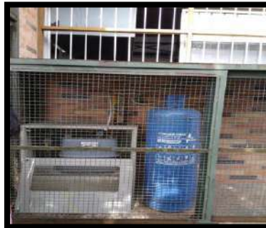
Fuente: Registro fotográfico Red de Gas Bloque 19
