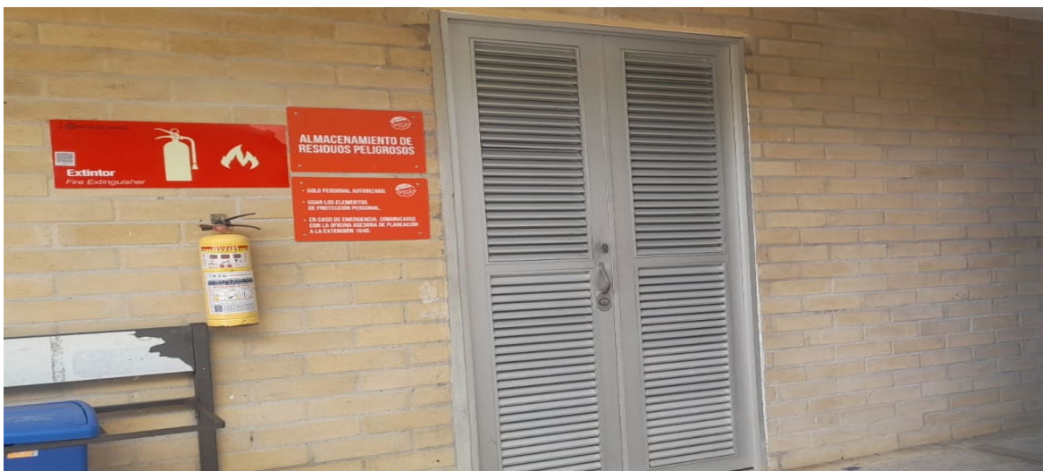
Imagen Acopio residuos peligrosos
